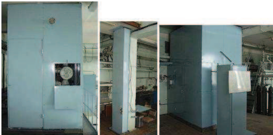
Figura 7.9. Instalación IPPE en Obninsk.
